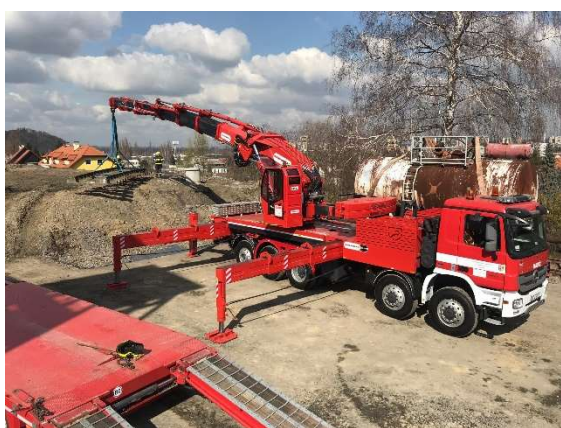
Březen – zemní práce a přemístění trenažéru v areálu ŠVZ Frýdek – Místek
