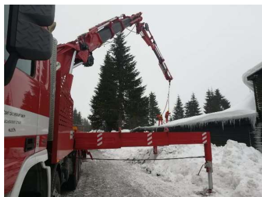
Únor – technická pomoc – odstranění nebezpečných stavů, odstranění sněhové vrstvy ze střechy vodárny v Božím Daru
