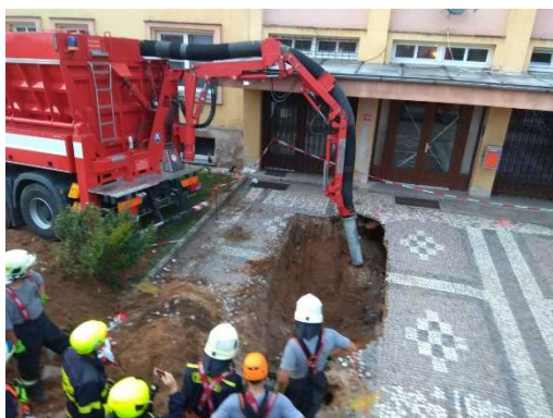
Srpen – technická pomoc – odstranění zeminy a suti po zřícení stropu sklepních prostor v Třebechovicích pod Orebem
