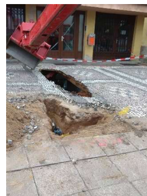
Srpen – technická pomoc – odstranění zeminy a suti po zřícení stropu sklepních prostor v Třebechovicích pod Orebem
