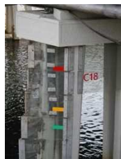
Značky na mostním pilíři
