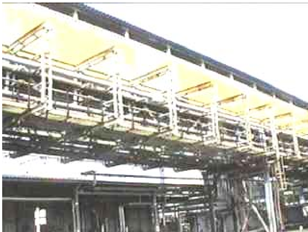
Obrázek č. 22 Potrubní most
