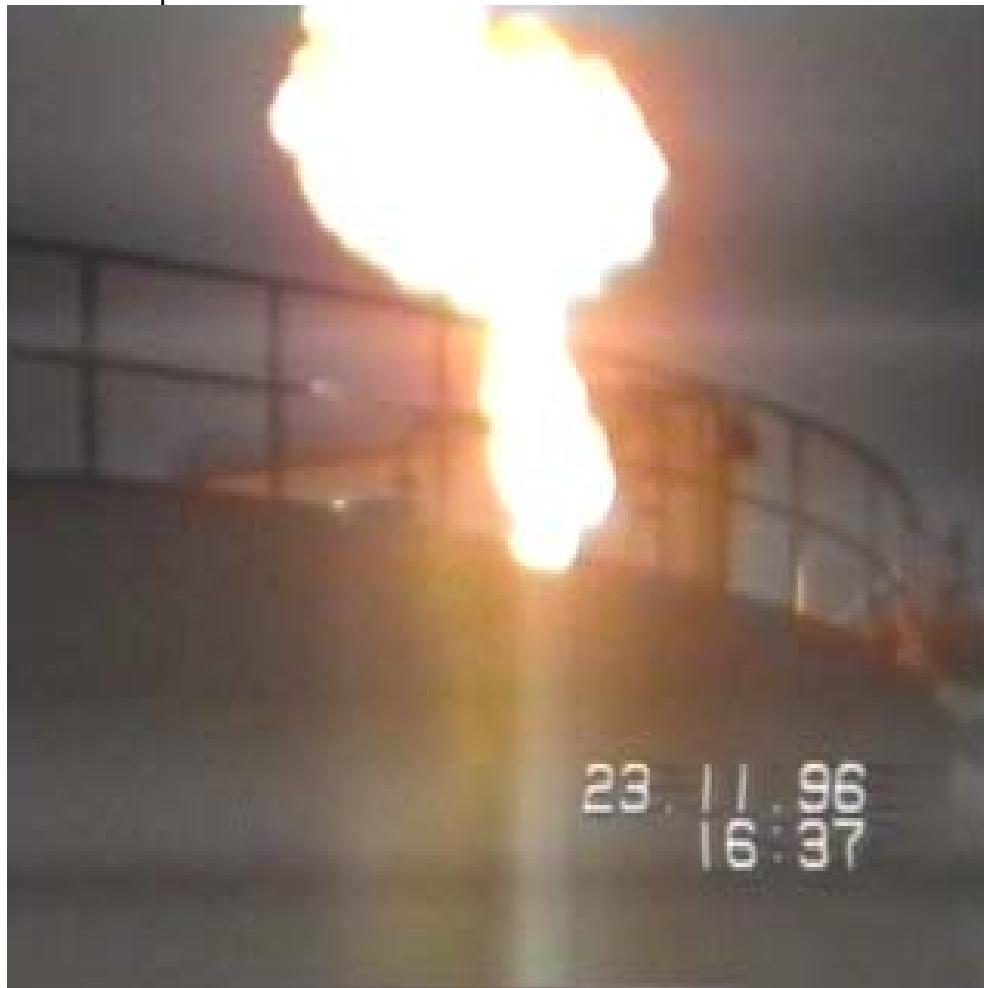
Obrázek č. 6 Hoření par unikajících z otvoru na víku nádrže s hořlavou kapalinou
