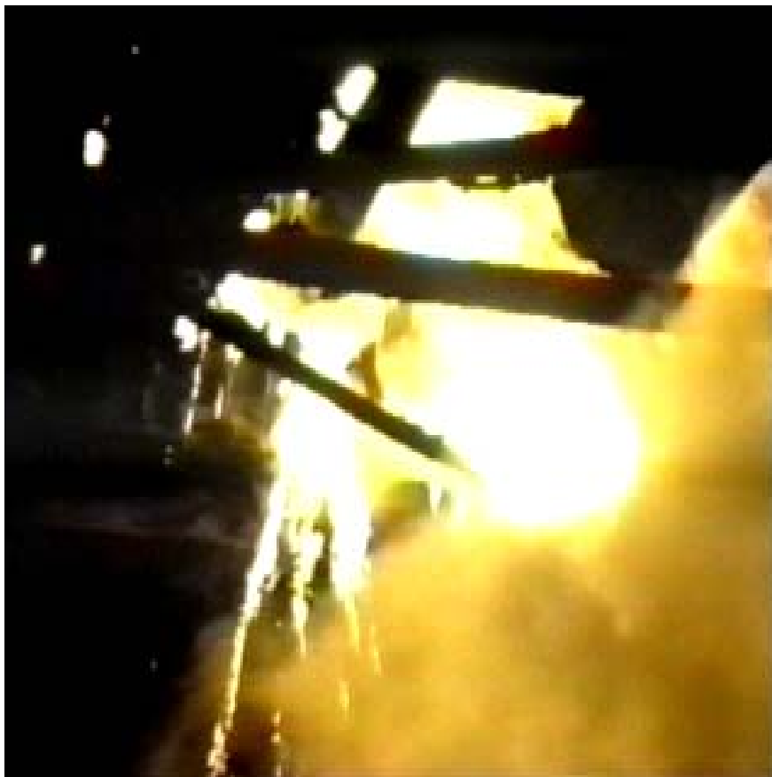
Obrázek č. 2 Hořící kapalina unikající z porušeného potrubí na potrubním mostě
