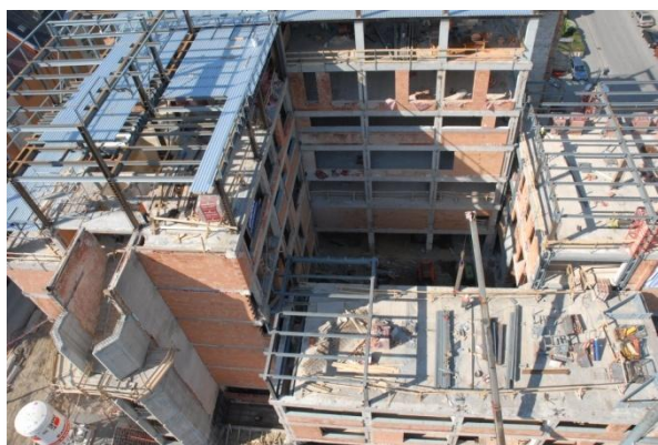
Pohled na stavbu z výšky stavebního jeřábu v dubnu 2009
