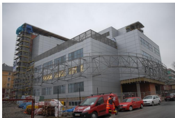
Prosinec 2009 – dokončování fasády, montáž technologií
