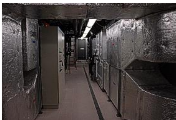
Jedna ze tří strojoven pro ovládání vzduchotechniky
