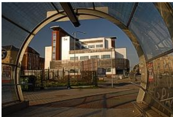
Pohled na budovu IBC z podchodu Stodolní
