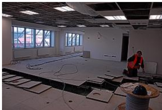
Montáž kabeláží do zdvojených podlah
