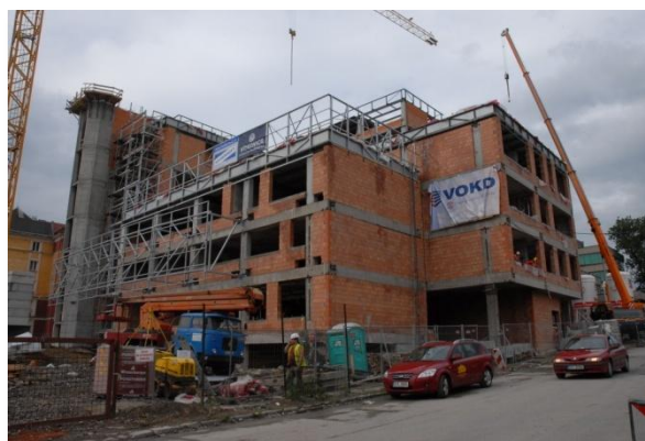
V červnu 2009 se stavba začínala rýsovat
