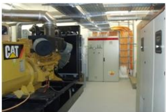
Jeden ze dvou modulů nepřetržitého napájení 500 kW
