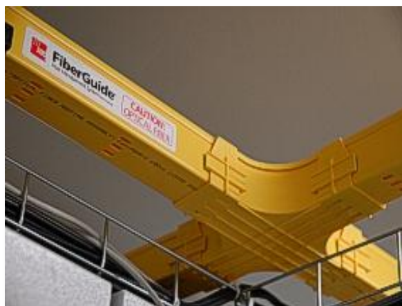
Další ukázka chybějící koordinace profesí. Vyvíjeli jsme značné úsilí, aby zhotovitel dílo realizoval v odpovídající kvalitě. (Na první fotografii kolize rozvodů vzduchotechniky a optické kabeláže, na druhém snímku realizace dle našich představ.)
