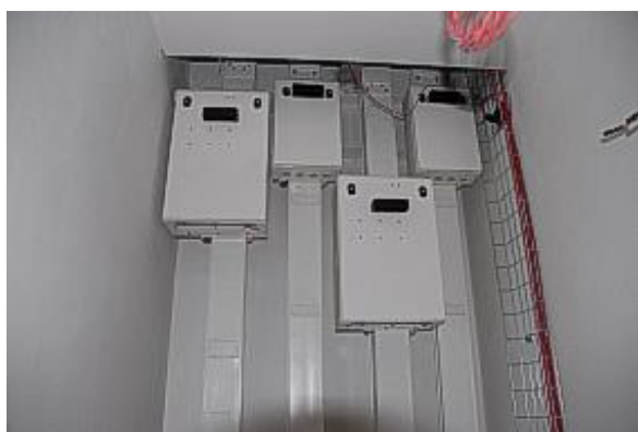
Montáž přípojnicových systémů v patrových rozvodnách.
