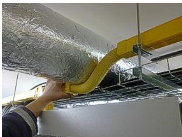
Další ukázka chybějící koordinace profesí. Vyvíjeli jsme značné úsilí, aby zhotovitel dílo realizoval v odpovídající kvalitě. (Na první fotografii kolize rozvodů vzduchotechniky a optické kabeláže, na druhém snímku realizace dle našich představ.)
