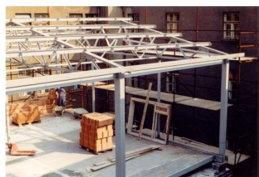
stavba CTV Ostrava 1994
