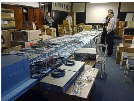
Akceptace HW komponent technologií provozu IBC
