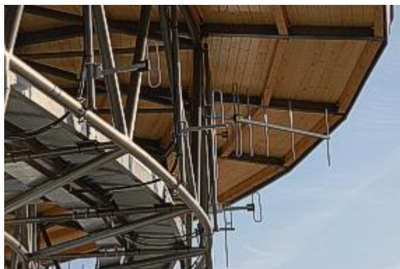
Instalace antén na střešním nosniku IBC
