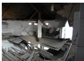
střecha MD Ostravica 2000
